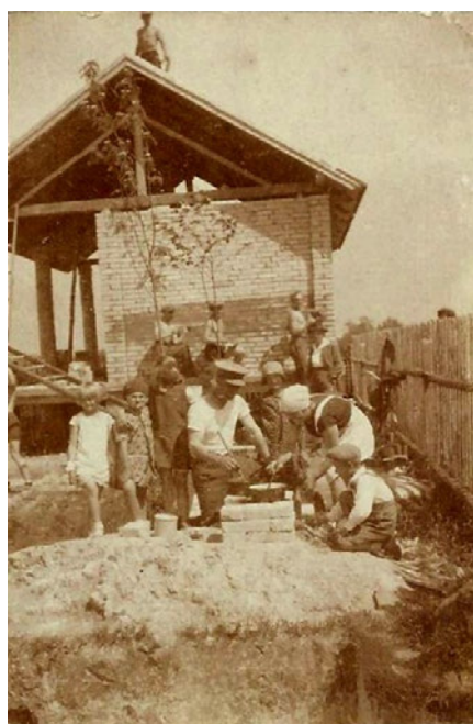
Foto 9: Stavba zděné šatny
